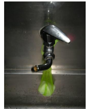
校舎内の水道をレバー式に交換
