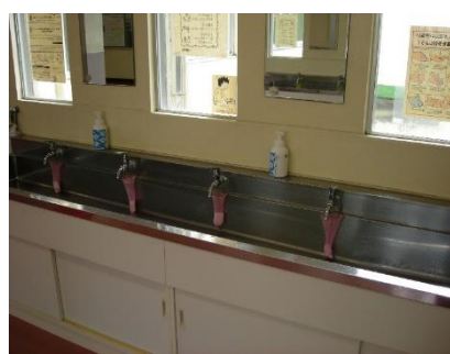
校舎内の水道をレバー式に交換
