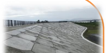
高さ11mの防潮堤
